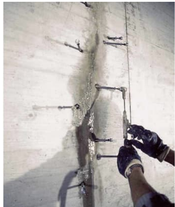
Beispiel Verpressung Wandriss
