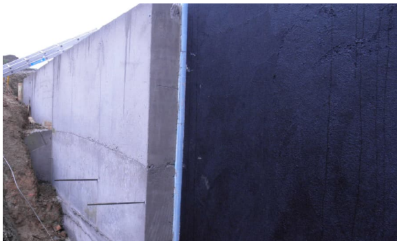
Beispielbild: 2K Dickbeschichtung
